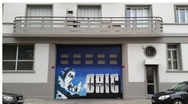
Un bâtiment des années 1960 ? Rue Claude Genin. Une ancienne caserne de pompier ou un concessionnaire auto ? La façade est élégante même après la réhabilitation récente.
