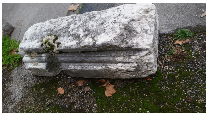
Un reste des anciens lavoirs dans les cours des bâtiments en U ?
