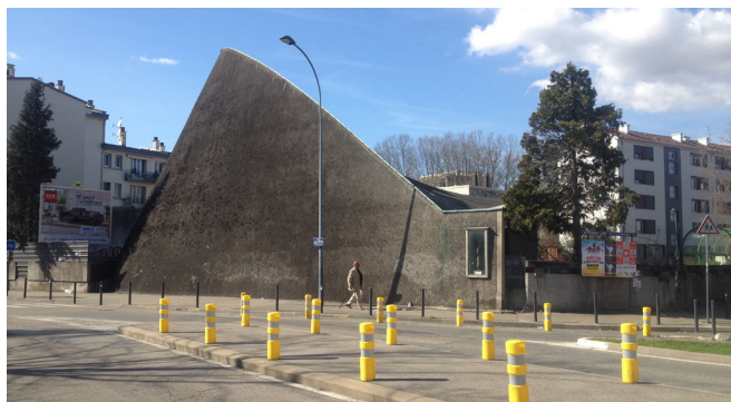
Église, matérialité et volumétrie : paroi roche, volume insolite.
