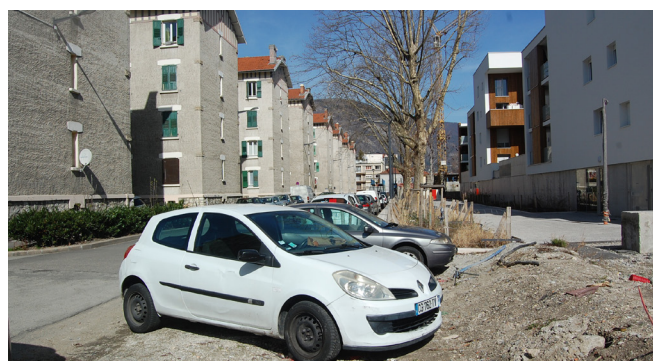
Il n'y a plus de place dans les cours de l'Abbaye. Les voitures se garent sur les talus du chantier de Châtelet.
