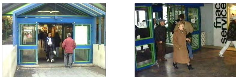
Figure 4 : Sas composé par un double système de portes automatiques
