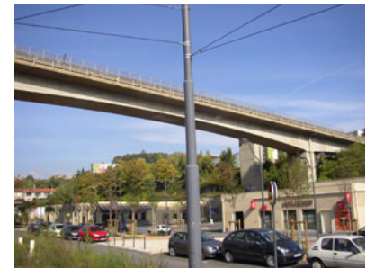
Le viaduc de Terrenoire
