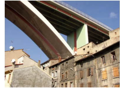
Le viaduc de Rive-de-Gier
