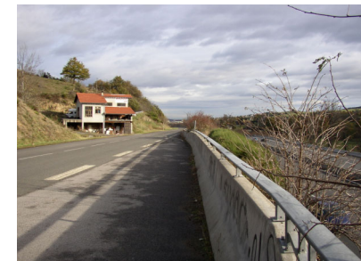
La voie de désenclavement
