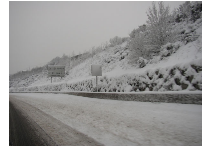
Le mur de soutènement de la voie de désenclavement
