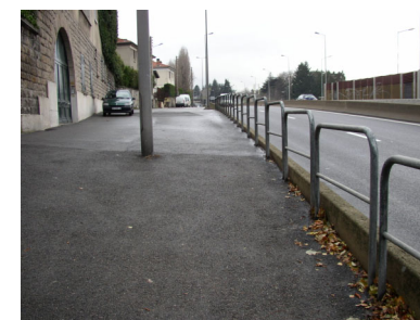
Rue en surplomb de voie
