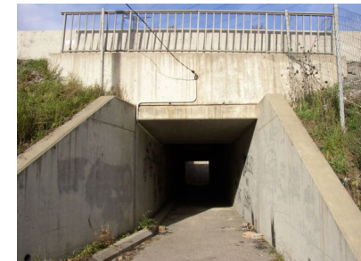
Une ancienne route de franchissement réduite à un passage piéton
