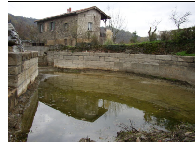
L'écluse du canal
