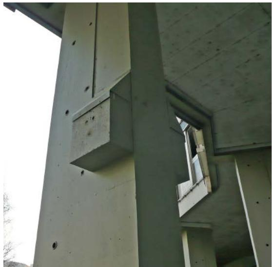
Les corbeaux permettant l'appui d'une nouvelle structure (ex. : mezzanine...)
